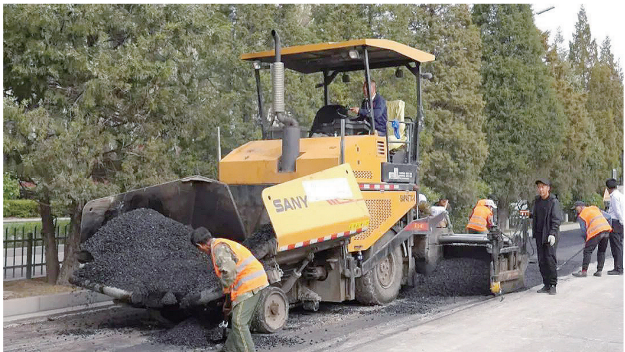
城市道路维护关系到城市形象和居民出行。这几天,我市正抢抓天气转暖的有利时机,对市区部分主干道进行大面积修整,努力让城市“颜值”再提升,居民出行更便利。在市区开发北路市府岗路段记者看到,大型机械正在紧张作业,进行路面切割、基层开挖等各项工作。施工方介绍说,这项工程从4月21日全面铺开,目前进展顺利。刘希军 张智宙 摄
