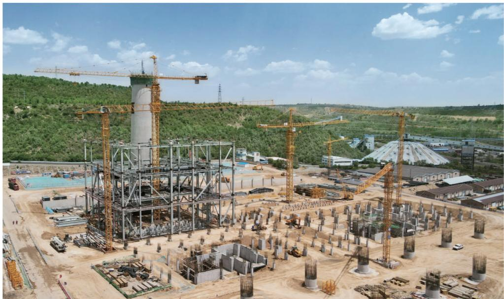
中煤朔州安太堡2×350MW低热值煤电项目基础工程已经完成,正在搭建1号、2号机组钢架铁塔。 薛礼伟 摄
