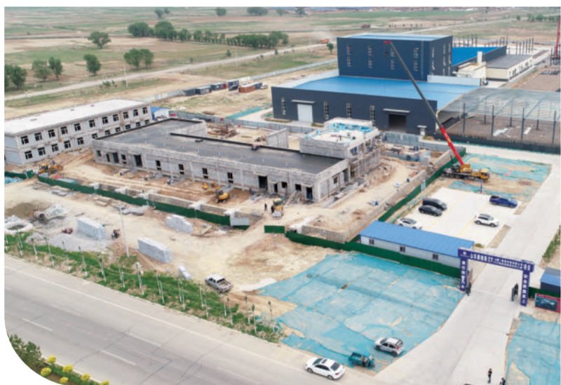
位于山阴县经济技术开发区的赢胜10万吨陶瓷纤维项目,现已完成一座厂房和四条生产线安装,具备试生产条件。
