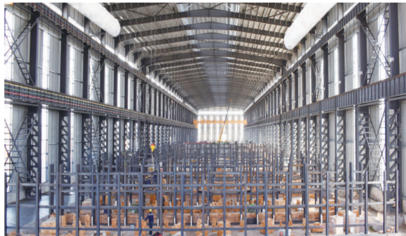
位于山阴县经济技术开发区的恒科年产6万吨锂电池负极材料项目,现已完成两座厂房和1号车间全部设备安装,具备试生产条件。
