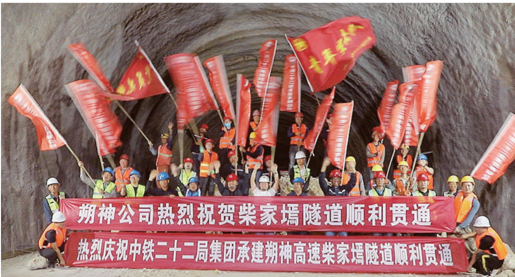
6月14日,历经635天的紧张施工,由中铁二十二局集团承建的呼北国家高速公路山西段朔神至神池段控制性工程柴家堽隧道顺利贯通,为朔神高速公路按时全线贯通打下坚实基础。孙荣祥 摄
