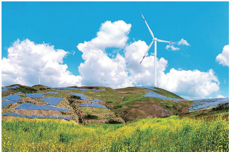
利民山上的风力发电和光伏发电
