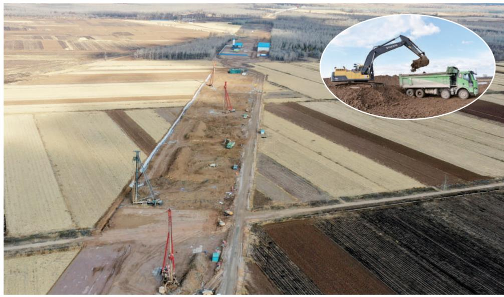
记者从市交通局获悉,朔州东站软基处理工程年底即将完成。据介绍,该工程CFG桩设计287361延米,已完成269617延米,剩余17743延米,完成93.8%,预计2023年7月路基填筑全部完成,为2023年东榆林特大桥箱梁架设提供强有力保障。图为东站软基处理工程施工现场。
