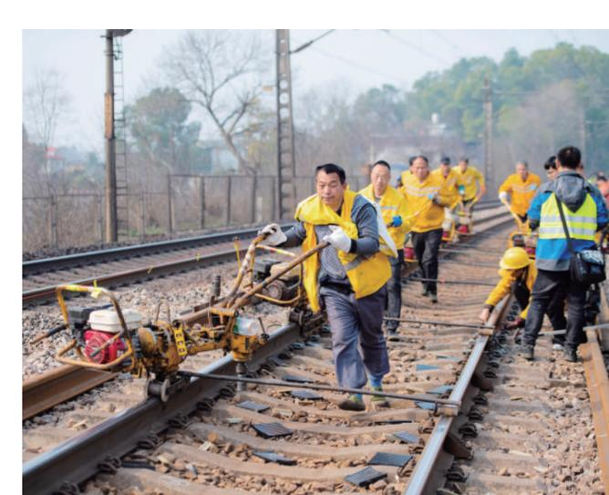
2月19日，在沪昆铁路娄底至湘潭东区间，工人在移动螺栓紧固机。近日，在沪昆铁路娄底至湘潭东区间，广铁集团广州工务大修段工人在不影响线路运行的情况下，抓紧时间对线路进行换轨施工。本次施工预计3月底完工。新华社记者 陈思汗 摄
