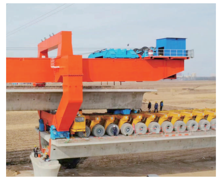
图为集大原高铁山阴段架梁作业有条不紊开展。
