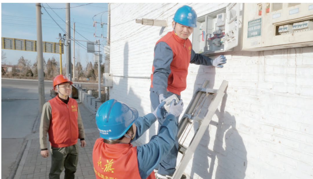
近日，国网怀仁市供电公司“亮旗”青年志愿者服务队开展学雷锋活动，发挥专业和技术优势，帮助乡村用电客户排查安全隐患，并深入到留守老人家中，进行义务更换入户线路、安装漏电保护装置等特色服务。 宋宏雄 摄
