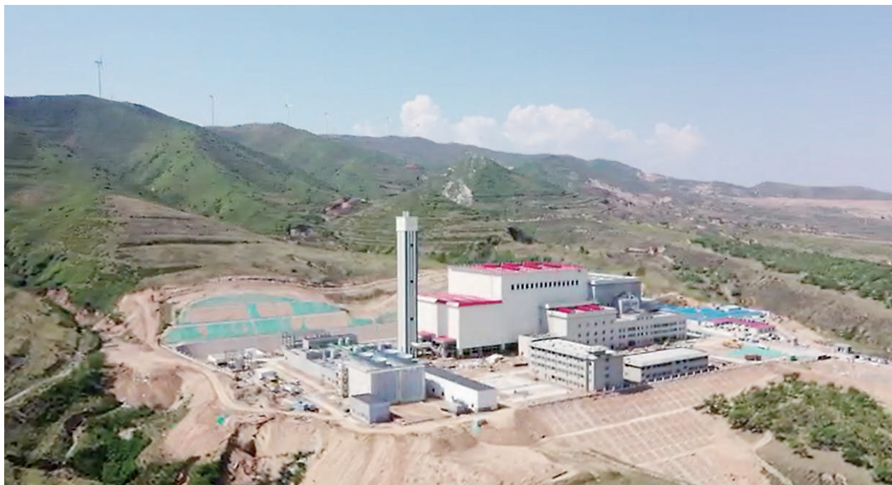
为妥善做好垃圾处置,我市大力实施南山环境能源项目,替代了生活垃圾传统填埋方式,实现垃圾减量化、资源化和无害化处理,让生活垃圾变为绿色电能。日前,我市首个生活垃圾焚烧发电厂正式并网发电,日处理生活垃圾1000吨,年发电量为1.939亿度。
