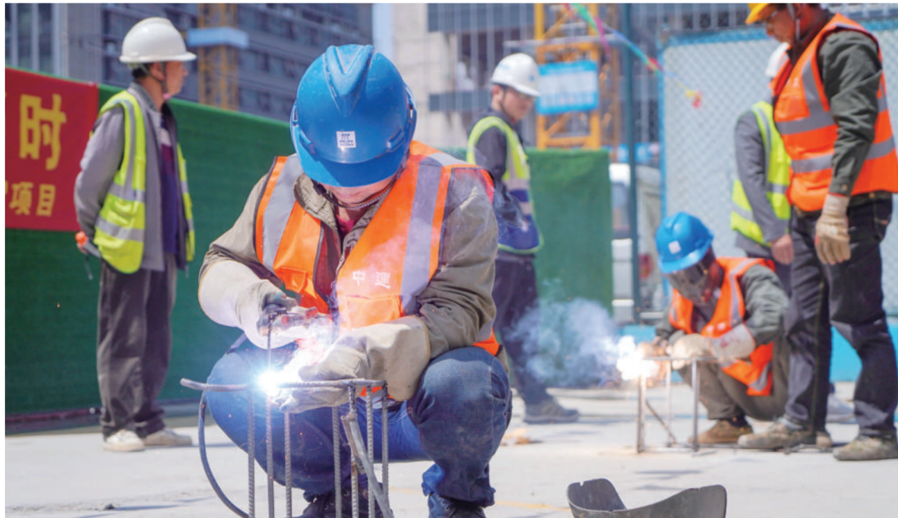
迎五一 赛技能 4月27日,在江苏南京华贸项目施工现场,建设者代表在中建三局浙江公司组织的“技能大比武”活动中参加钢筋焊接比赛。当日,多地举行技能比武活动,建设者们一展身手,迎接“五一”国际劳动节。 新华社记者 李博 摄
