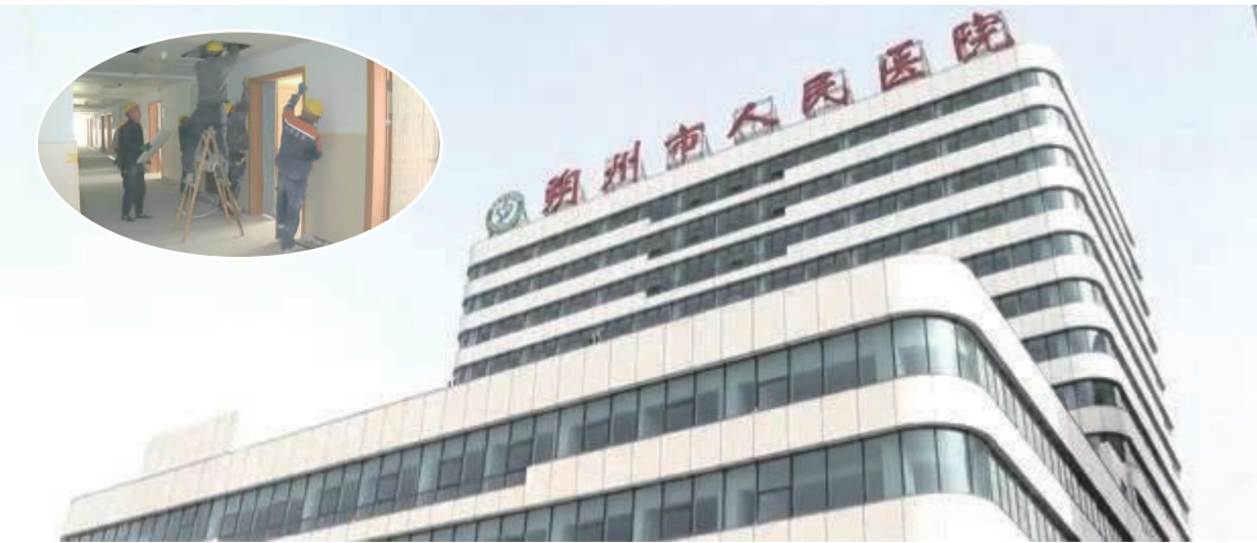
作为我市一项重点民生保障项目,朔州市人民医院改扩建工程对优化诊疗环境,提高卫生健康供给质量和服务水平,推进健康朔州建设具有重要意义。眼下,项目建设进入尾声。 刘增 王丽花 张晓婷 摄
