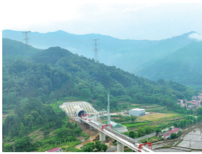
这是中铁十局池黄铁路岭上村隧道进口。5月21日,由中铁十局承建的池(州)黄(山)铁路全线最长隧道——岭上村隧道顺利贯通。池黄铁路全长约125公里,设计时速350公里,是武(汉)杭(州)快速铁路通道的重要组成部分。 新华社发 刘玉才 摄
