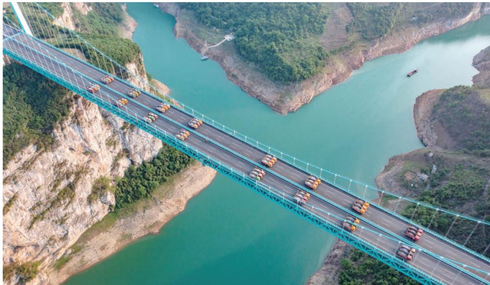
这是5月21日拍摄的金峰乌江大桥静态荷载试验现场。当日，由贵州路桥集团承建的金峰乌江大桥进行静态荷载试验，48辆满载砂石的大型货车有序行驶到固定的位置进行对称、偏心检测，检验桥梁结构整体的施工质量与受力性能，为桥梁竣工验收提供科学依据。金峰乌江大桥是贵阳金沙至古兰(黄金古)高速公路项目的控制性工程，桥梁全长1473.5米。
