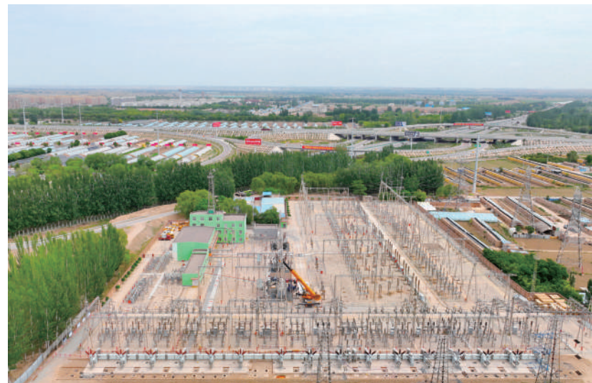
5月27日,电力工人在工程现场进行检修作业(无人机照片)。近日,国网银川供电公司变电检修人员对连续运行27年的掌政220千伏变电站1号主变压器进行大修,确保迎峰度夏期间银川电网安全可靠运行。
