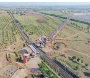
5月29日,集大原高铁跨京包铁路连续梁转体作业中。当日,位于内蒙古乌兰察布市的集大原高铁(集宁至大同至原平高速铁路)建设重点控制性工程——察哈尔右翼前旗特大桥跨京包铁路连续梁转体取得突破性进展,为全线如期建成通车奠定基础。
