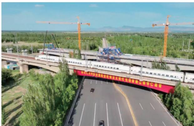
此次合龙的连续梁全长177.7米,分为2个48米的边跨及80米长的主跨,合龙段上跨怀仁高速匝道,临近韩原铁路既有线,且处于架梁的关键线路。在不影响关联线路行车安全之外,全力保障工程质量尤为重要,施工方仅用了115天便完成了45个节段的施工,比原计划提前15天完成了工程任务,交出了亮眼成绩单。
