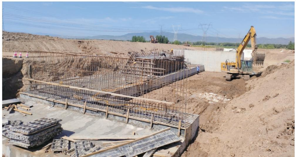
恢河后寨段生态综合治理工程朔州城区晋北地区高原风沙源生态保护和修复重点项目(水利)中的一项重要生态修复建设工程。项目的主要建设内容有修建蓄水钢坝一座、修建河道主槽护岸、河道清淤等，以达到进一步改善恢河生态景观、提高河道防洪抗灾能力、提升沿河地区环境质量的目。图为正在修建中的恢河后寨段生态综合治理工程蓄水钢坝。刘淑花 摄
