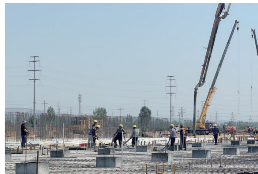
朔州低辐射硅芯产业园区是朔州市委市政府深入贯彻省委省政府战略部署，抢抓国家政策机遇，积极落实“双碳”目标，倾力打造的千亿元级低辐射硅芯产业园区。图为园区内“三一”5GW单晶硅项目的施工现场，该项目预计今年9月15日举行点火仪式。李晶 摄
