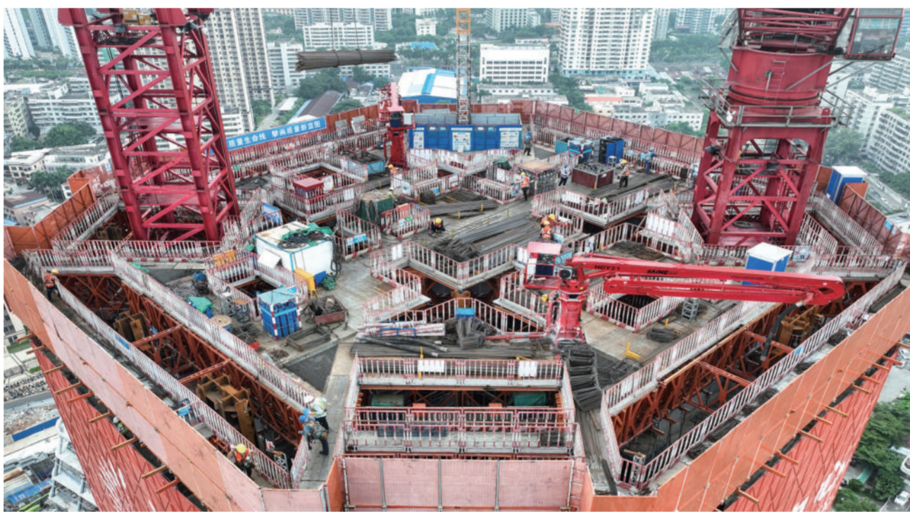
9月5日,中建三局的工人在海口市海南中心项目的“空中造楼机”内施工作业。日前,由海南控股旗下海南机场股份投资建设、中建三局承建的海口市海南中心项目核心筒第8次顶升顺利完成,标志着该项目迎来突破100米节点。据悉,海南中心总建筑面积达428米,集观光游览、超五星级酒店、高级写字楼、精品商业等多功能于一体,项目建成后将刷新海口天际线,成为海南第一高楼。新华社记者 张丽芸 摄
