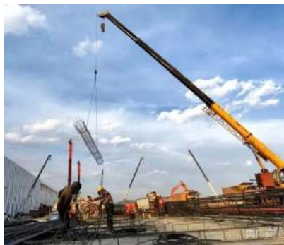
三一朔州一期5GW单晶硅项目工地现场 谢宏 摄
