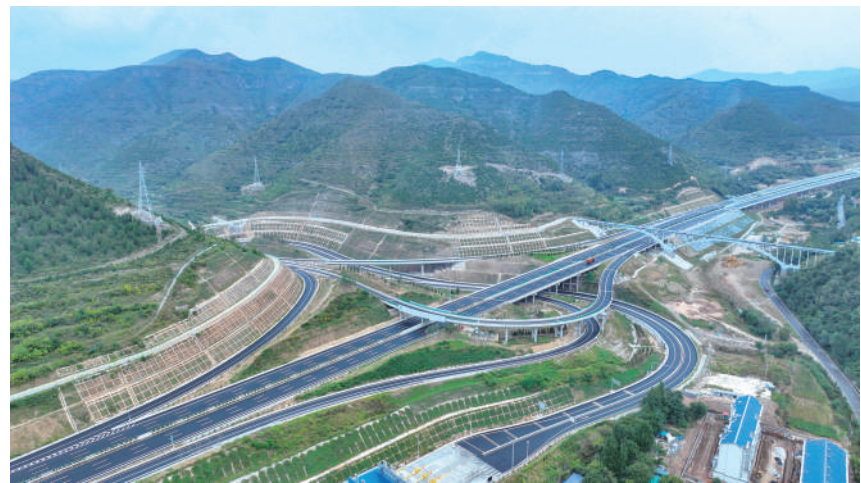
9月24日在山东省青州市拍摄的济青高速济潍段黄花溪互通立交。当日,由山东高速集团投资建设的济青中线济潍段零碳智慧高速正式通车,至此,济青中线全线贯通。济青中线济潍段是山东省“九纵五横一环七射多连”高速公路网中“射三”线,全长161.86公里,设计速度120公里/小时,双向六车道。新华社发 王继林 摄
