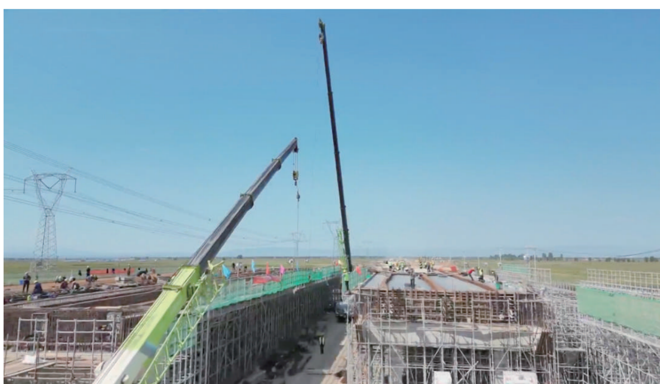
朔州迎宾大道是我市的一项重要民生工程。为早日完成项目建设任务,两节期间,迎宾大道的建设者们加班加点抢工期、赶进度,全身心地投入到一线施工中,积极推进项目建设,为朔州城市发展贡献力量。朔州迎宾大道位于朔州经济开发区临港物流园区,与朔州高铁站、机场连接线相连,全长13千米,宽62米,采用主路双向6车道加辅路。项目建成后,将成为连通城区和朔州东站的快速通道,使我市对外交通衔接更加便捷顺畅。 刘希军 李妍 李晓 摄
