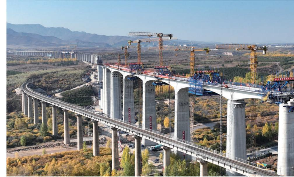
10月12日拍摄的集通铁路电气化改造工程多伦河特大桥刚构连续梁。当日,在内蒙古自治区赤峰市克什克腾旗,中国铁路呼和浩特局集团有限公司集通铁路电气化改造工程多伦河特大桥刚构连续梁合龙。该刚构连续梁由中铁电气化局集团有限公司负责施工,全长337.75米,为六孔跨结构,是全线路度最大的连续梁。据了解,集通铁路于2020年4月开始电气化改造,改造完成后将进一步便利周边群众出行及促进区域经济社会发展。 新华社记者 贝赫 摄
