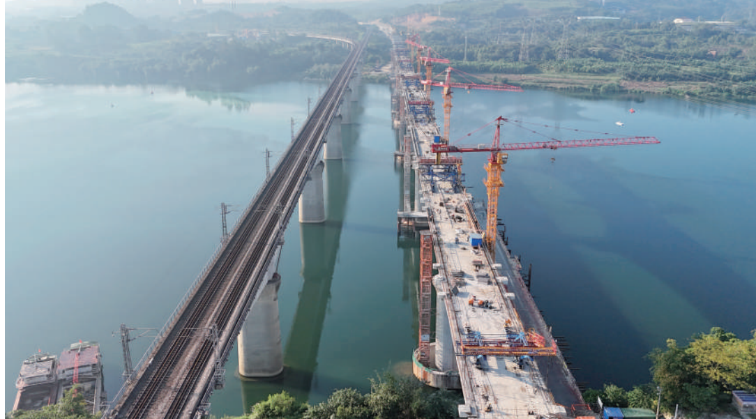
这是合龙后的湘桂铁路柳江双线特大桥(右)。10月15日凌晨，位于广西柳州市的湘桂铁路柳江双线特大桥连续梁顺利合龙，为柳州铁路枢纽扩能改造工程实施今年年底竣工开通提供保障。柳江双线特大桥全长1688米，是湘桂铁路柳州枢纽全线的控制性工程。
