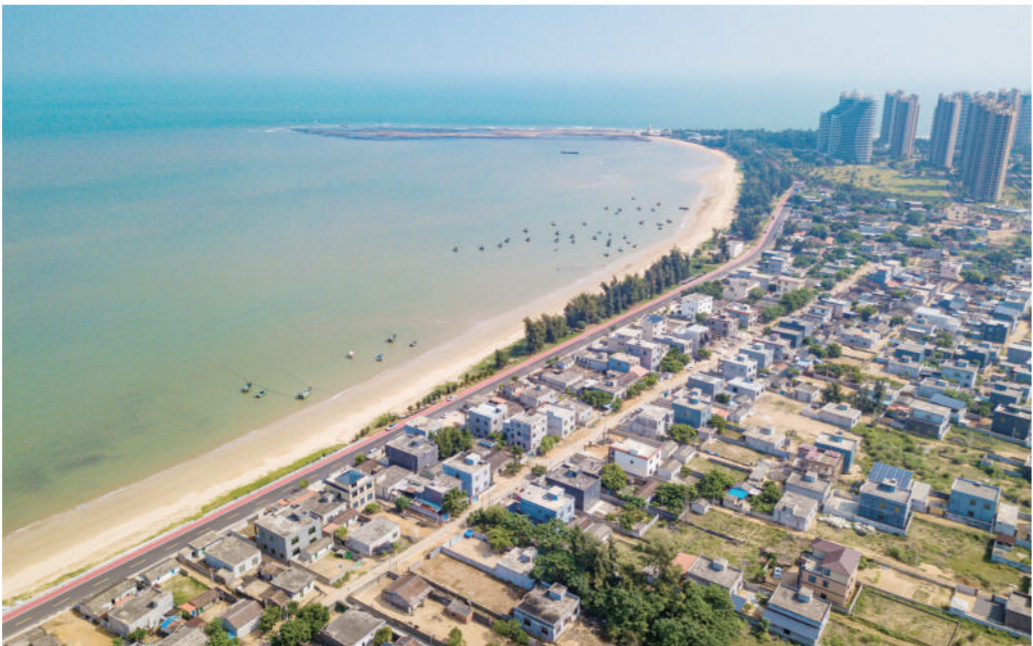
10月15日拍摄的海南环岛旅游公路临高段景色。 海南环岛旅游公路是建设海南自贸港和创建国际旅游消费中心的先导性重大基础设施项目,该公路主线总里程988.2公里,串联沿途特色港湾、海角、特色小镇和旅游景区、滨海度假区等。海南环岛旅游公路临高段全长约58公里,目前主线路基段已建设完成,工人们正在对文澜江大桥进行桥面铺装、护栏、拱肋面漆喷涂等施工。 新华社记者 蒲晓旭 摄
