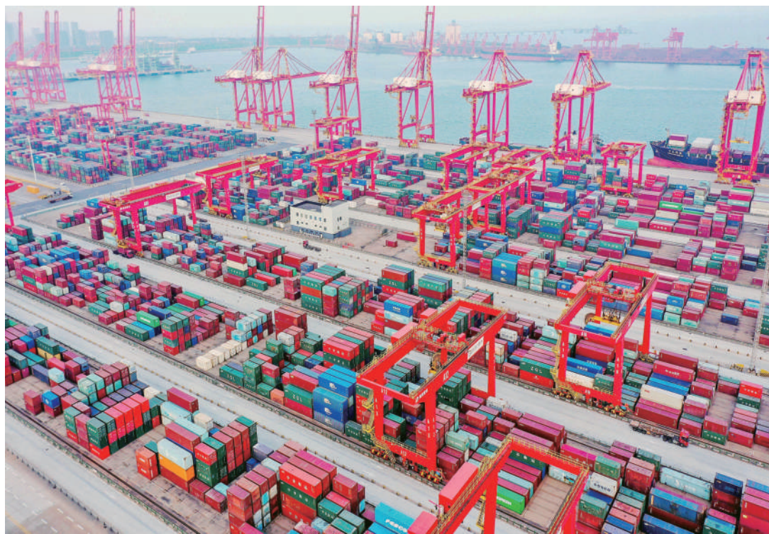
10月23日拍摄的山东港口日照港集装箱码头。记者从山东港口日照港了解到，今年前三季度日照港完成货物吞吐量同比增长5.7%，集装箱吞吐量同比增长7.1%，其中，外贸集装箱吞吐量同比增长137.4%，呈现出稳步向好态势。新华社记者 郭绪雷 摄
