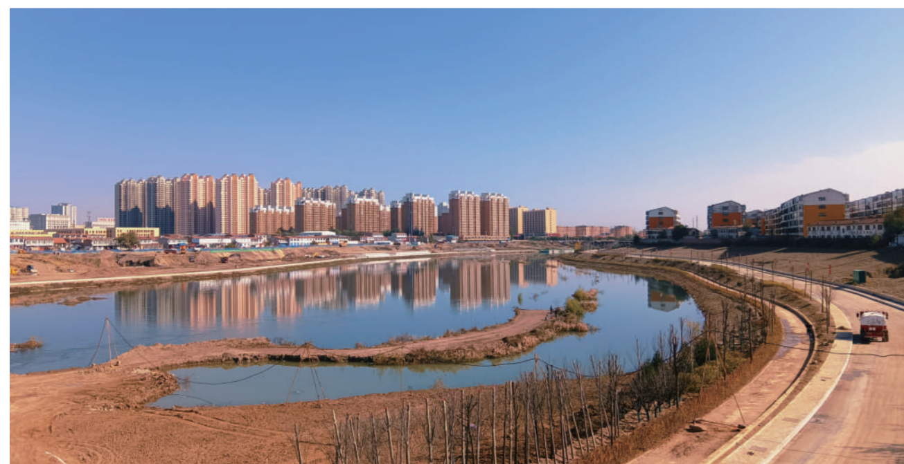
金秋十月收获季,项目建设战犹酣。时下,朔州市七里河生态环境综合治理二期工程项目进入建设高峰期。该工程项目主要包含新建蓄水拦水坝、生态堤防、绿化景观公园、沿河临水面景观人行通道、北岸堤顶道路、人行天桥、体育活动场所、一期工程增补工程等。
