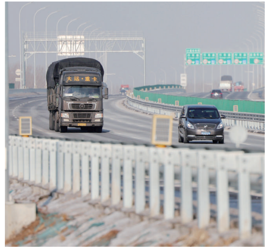
12月28日,车辆在京雄高速公路北京段上行线。当日,京雄高速公路北京五环至六环段顺利贯通。至此,京雄高速全线通车运营。京雄高速是北京连接雄安新区的直通高速公路,主线全长约97公里,其中北京段约27公里、河北段约70公里。从北京西南五环到雄安新区,全行行驶时间约1小时。
