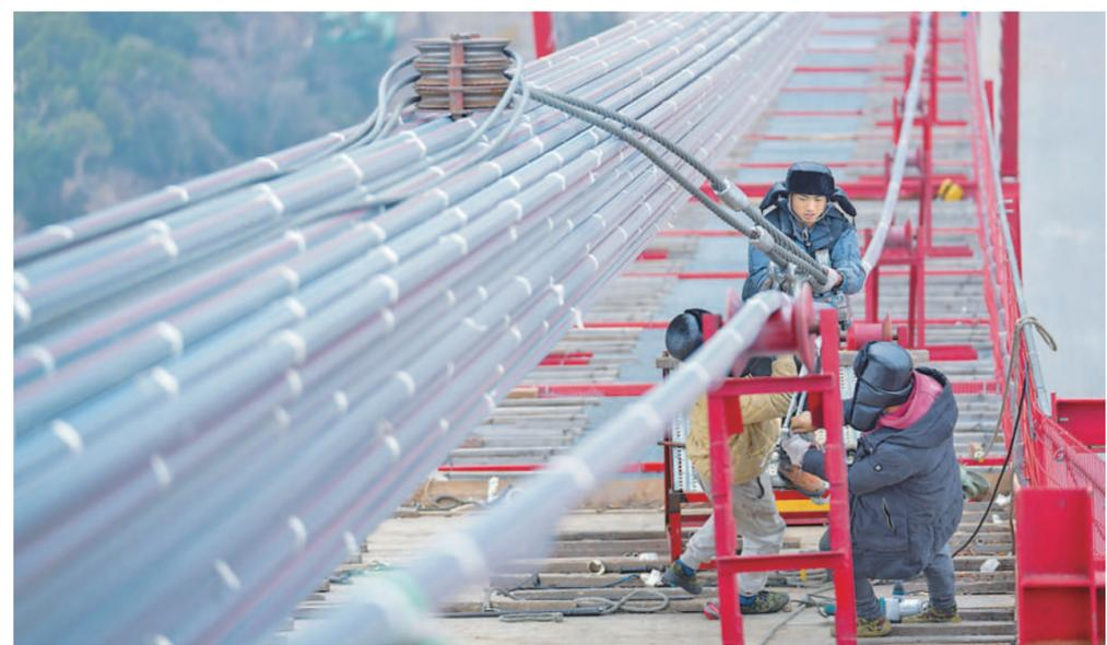
1月30日,在安徽,G3铜陵长江公铁大桥施工现场,施工人员进行主缆索股入鞍精调工作。当日,大桥最后一根主缆索股入鞍精调完成,下一步将推进紧缆、索夹和吊索安装等工序。大桥全长11.88公里,主跨988米,项目建成后将成为具有高速公路、城际铁路、货运铁路3种过江功能,对完善区域综合立体交通网具有重要意义。 陈磊 摄 据《人民日报》
