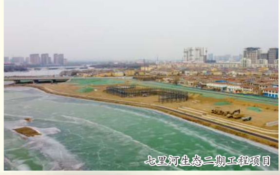
七里河生态二期工程项目
