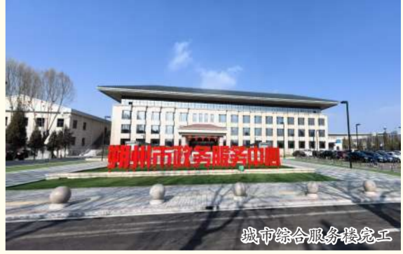
城市综合服务楼竣工
