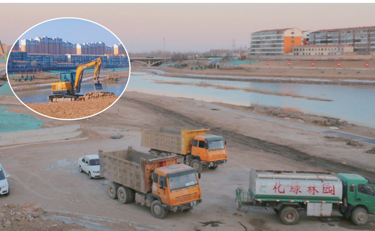
人勤春来早,奋进正当时。3月的朔州,气温逐渐回升,位于市区的七里河生态环境综合治理二期工程项目工地现场,各类工程机械繁忙有序地工作着,一派生机勃勃的景象。项目部全体成员抢抓春季施工的黄金季节,以“开工即大干、决战即冲刺”的心态,铆足干劲,苦干实干,保质保量完成一个又一个节点目标。 赵福胜 摄
