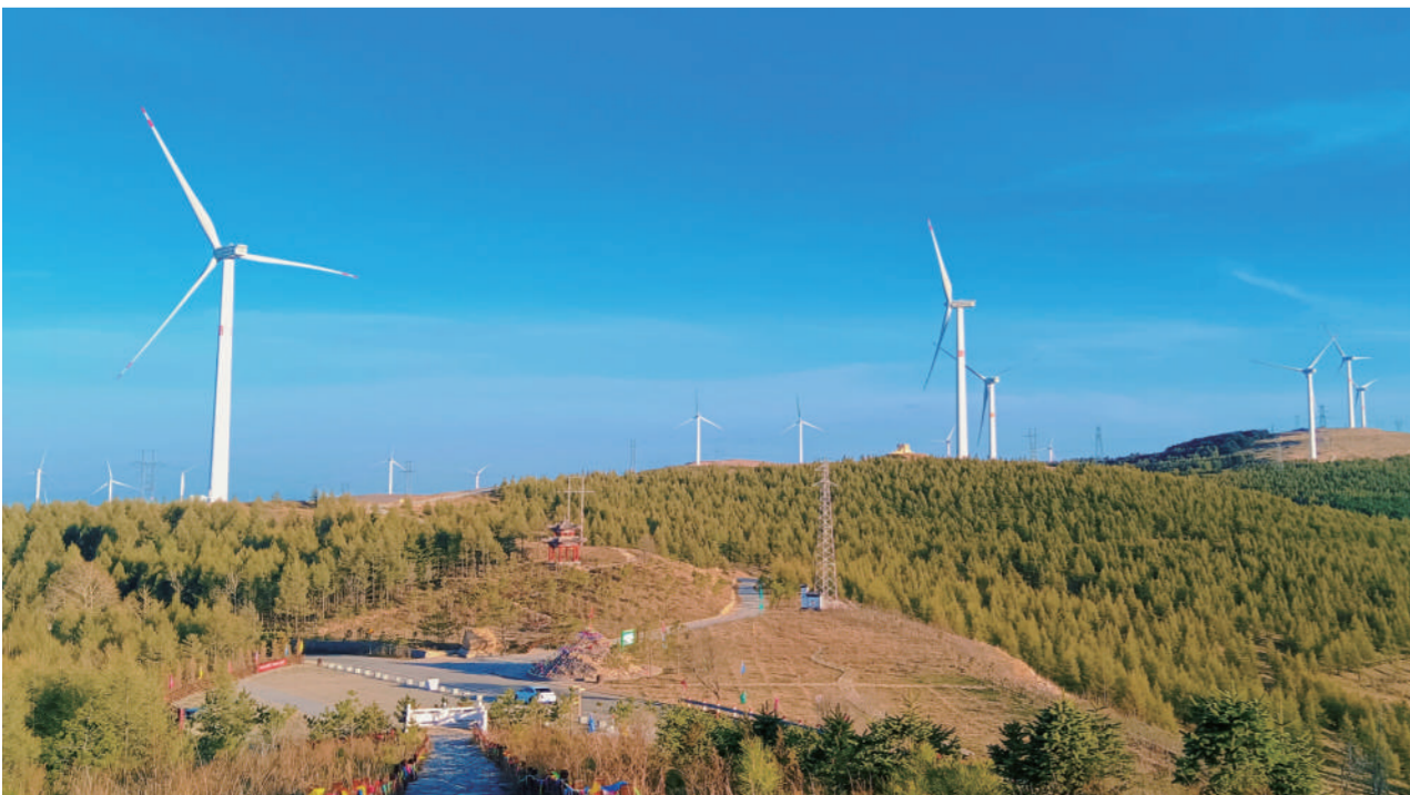
近年来,我市围绕实现碳达峰、碳中和战略目标,全面优化能源结构,大力发展风电、光伏绿色能源产业,源源不断向国家电网输送清洁能源,也为全市经济发展注入强大动能。图为位于朔城区利民镇的大唐利民风电场。赵福胜 摄
