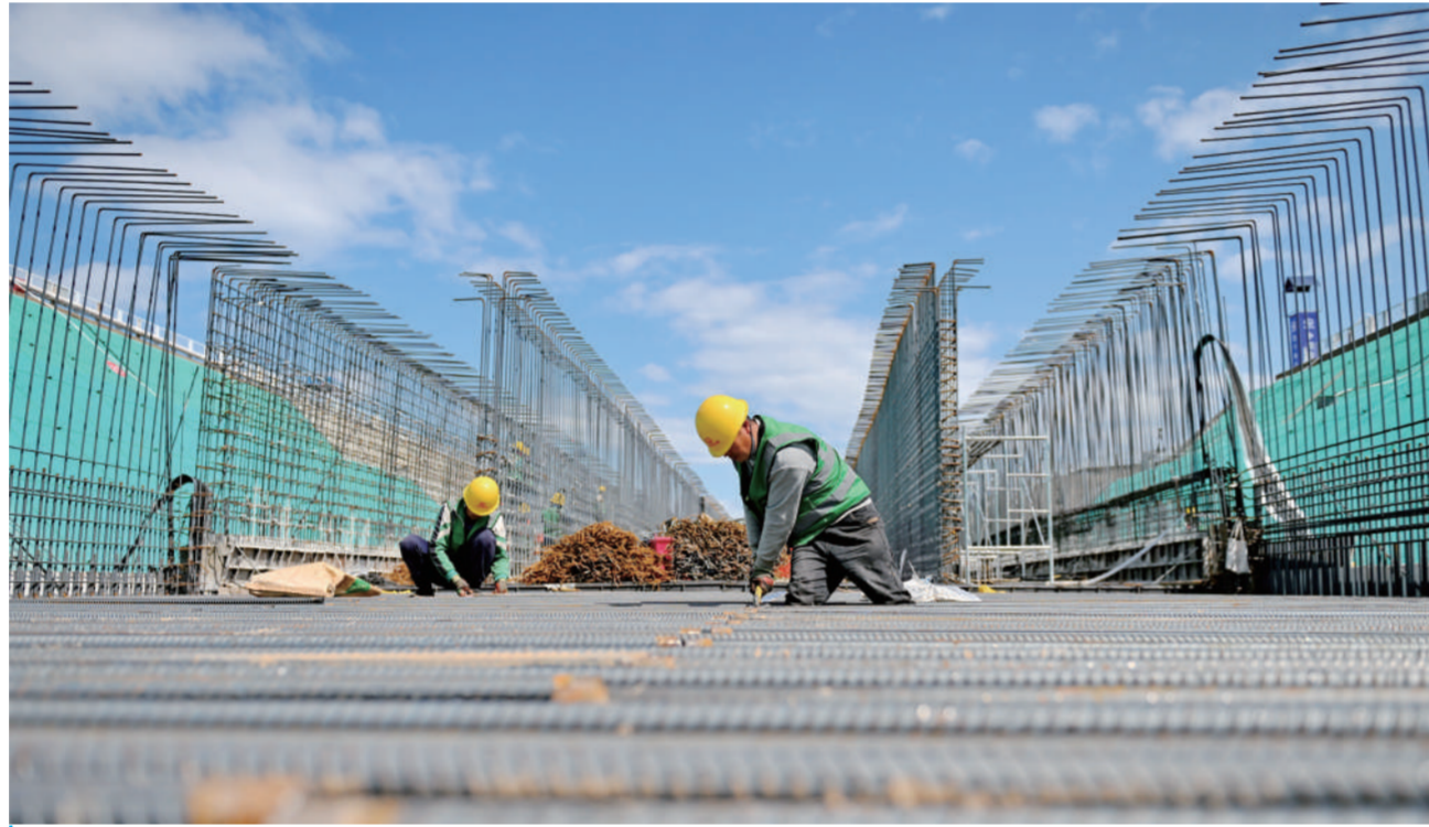
4月23日,中铁四局工人在雄安新区起步区NA12市政道路和综合管廊(二期)项目建设现场施工。目前,由中铁四局承建的雄安新区起步区NA12市政道路和综合管廊(二期)项目建设现场一派繁忙,数百名建设者抢抓春季施工时机,稳步推进工程。 新华社记者 牟宇 摄
