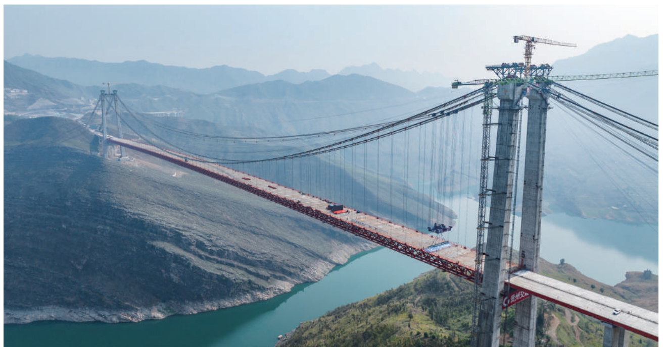
景江大桥吊梁合龙施工现场。当日,随着最后一段钢桁梁吊装到预定位置,贵州交建集团投资建设的纳晴高速景江大桥顺利实现合龙,为纳(雍)晴(隆)高速全线建成通车打下坚实基础。景江大桥位于贵州省晴隆县和普安县交界处,大桥全长1849米,主跨1080米,桥面至江面最高距离380米。 新华社记者 陶亮 摄
