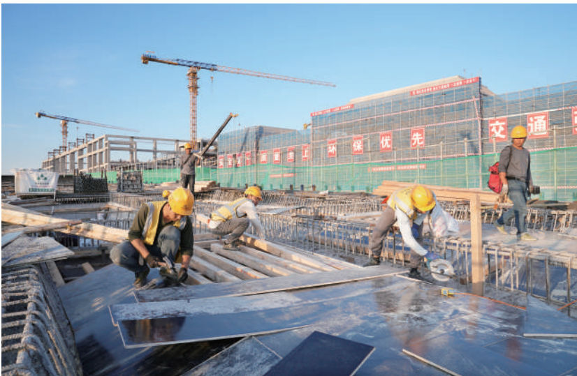
高铁站前广场高架桥木工班工人加班加点搭建基础支架。
