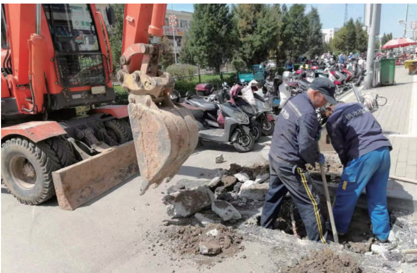
市城发供水公司工作人员抢修破损管网。
