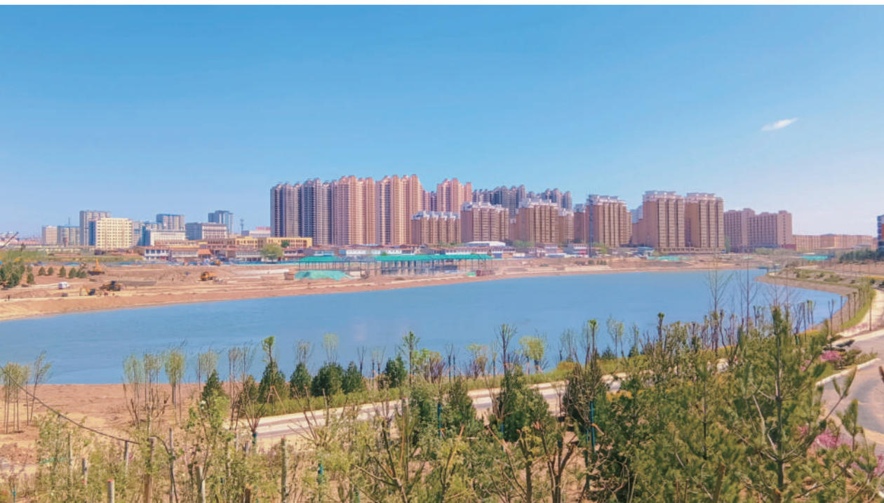
随着七里河生态环境综合治理二期工程项目的全面推进,备受市民关注的绿化景观公园已显现雏形,即将掀开神秘面纱。 赵福胜 摄
