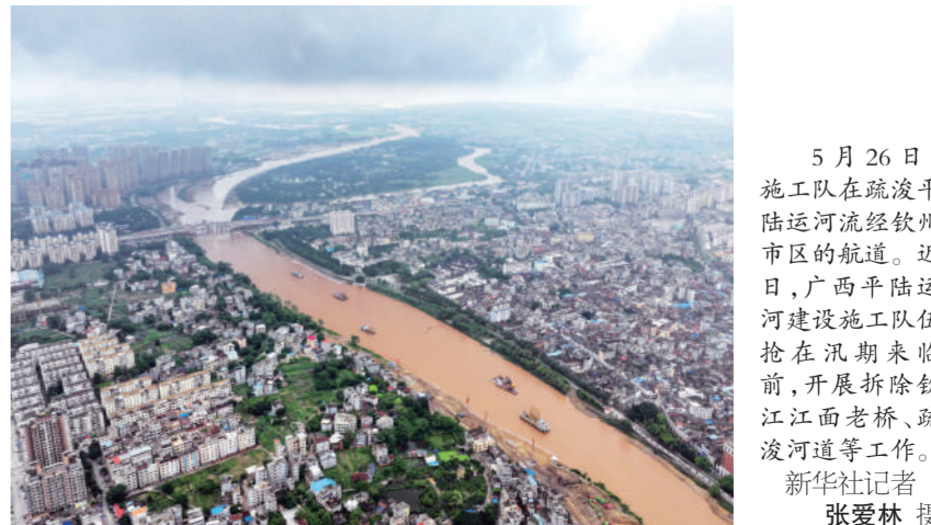
5月26日，施工队在疏浚平陆运河流经钦州市区的航道。
