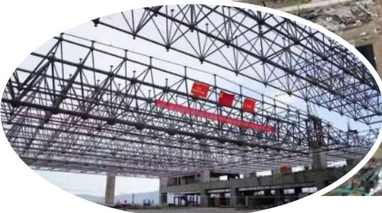
近日,由中铁建工集团承建的新建集大原高铁站房2标朔州东站站房,经过29天紧锣密鼓的吊装、焊接作业,一座重达500多吨的站房钢结构网架缓慢提升到位,标志着朔州东站站房建设取得了重大突破。
