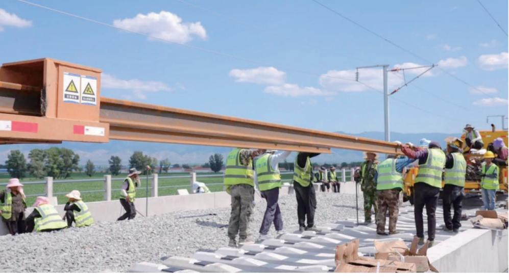
盛夏时节,骄阳似火,集大原高铁山西段铺轨作业如火如荼。工人赶工期、战高温,以每天6到8公里的进度铺设钢轨,近日集大原高铁铺轨延伸至朔州东车站区,这标志着集大原高铁山西段铺轨工程过半。 刘希军 高伟坤 摄
