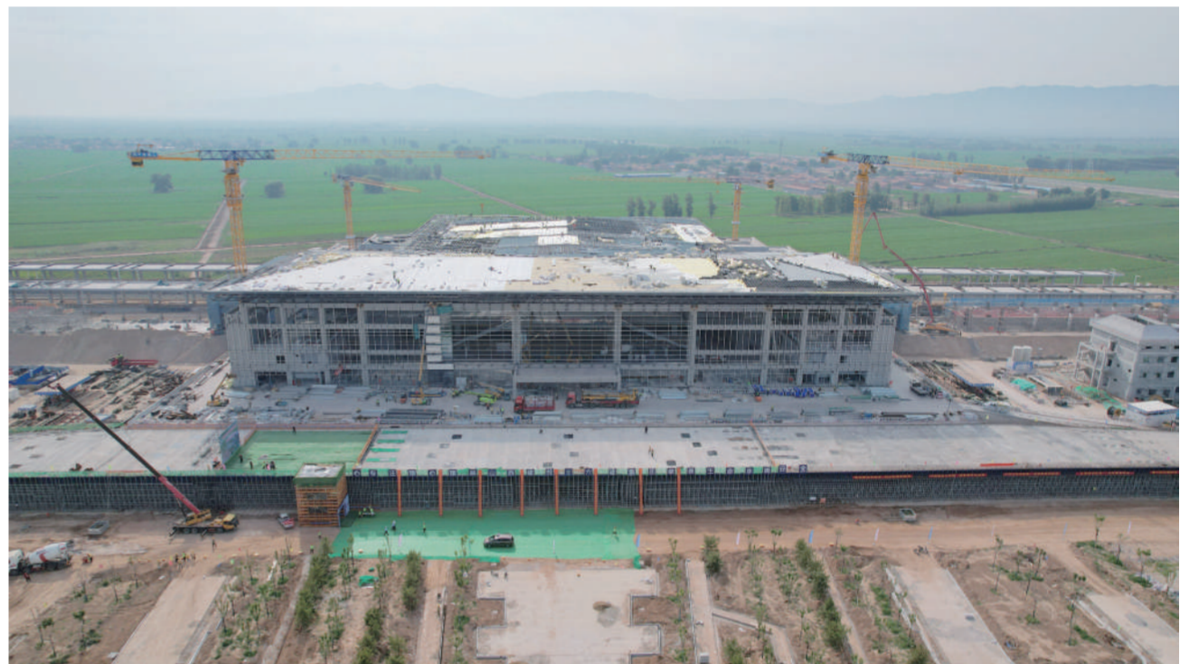
图为施工现场。 高文武 摄
