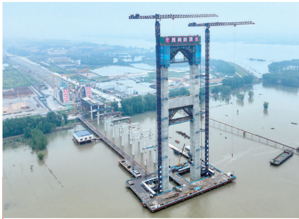
7月14日拍摄的武汉长江大桥主塔施工现场。当日,由湖北交投投资、中铁大桥局承建的武汉长江大桥主塔全部封顶。大桥采用双塔单跨设计并一跨过江,主跨1860米。作为鄂州国际物流核心枢纽的综合配套工程,武汉长江大桥是鄂东空铁、空陆联运立体交通运输体系的重要过江通道,也是推动黄冈、鄂州、黄石三市跨江联动开发,促进三市一体化发展的关键工程。新华社记者 杜子璇 摄
