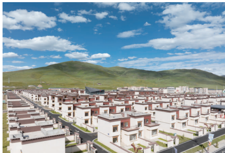
色达县色柯镇约若新村。8月10日,四川甘孜藏族自治州色达县色柯镇约若新村举行了交房仪式,240户牧民将变成城镇居民。曾经的约若村因年代久远,呈现出老、旧、破的现状。当地政府对2022年启动乡村振兴示范项目建设,整合资金在色达县城郊建设住房240套,并在改造和提升新村设施的基础上,打造民宿产业和非遗展示中心,让这里成为全县棚户区改造及乡村振兴的特色示范新村。 新华社记者 江宏景 摄
