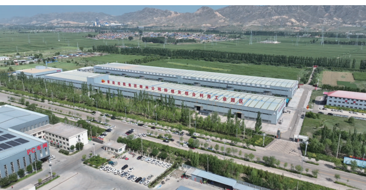
图为晋能控股集团朔州公司粉煤灰综合利用工业园区标准化厂房。高文武 摄
