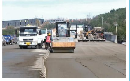
们头戴安全帽,身着反光马甲,正按照 工序铺设水稳,检查水稳摊铺碾压质 量,确保每一个环节都符合设计标准。
