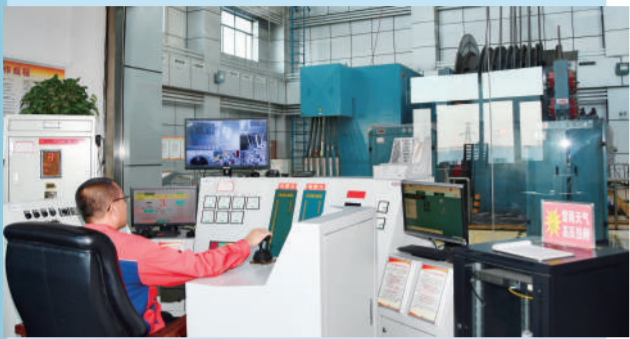
副立井提升作业
