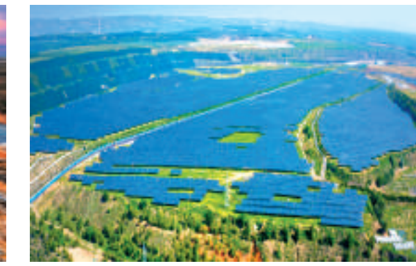
中煤平朔100MW光伏项目
