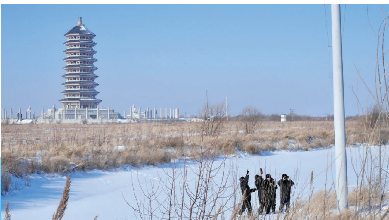
1月13日,国网抚远市供电公司工作人员在黑瞎子岛上对10千伏三管线路进行巡检。春节临近,在地处我国陆地最东端的黑龙江省抚远市,国网抚远市供电公司的工作人员踏雪巡线,在黑瞎子岛上对10千伏三管线路进行巡检,保障用电安全。 新华社记者 徐凯鑫 摄
