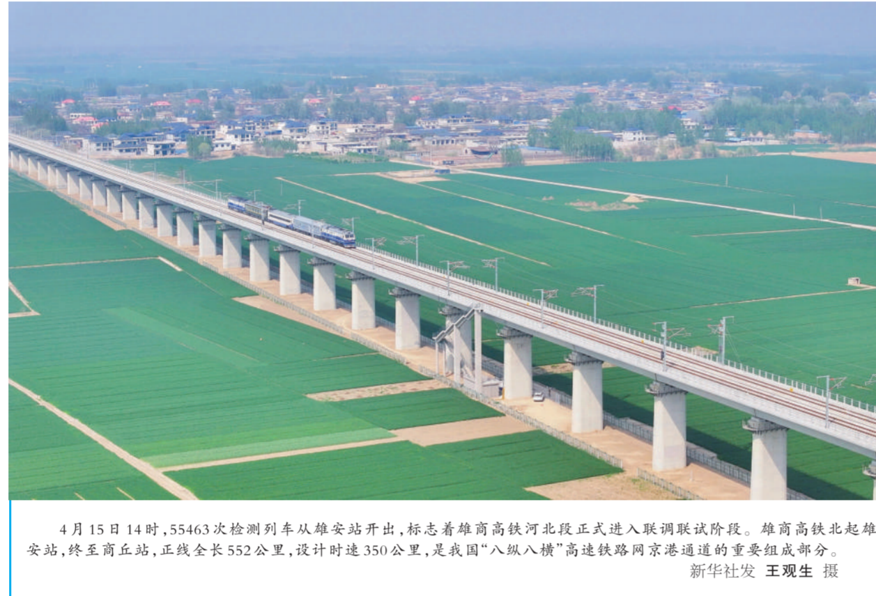
4月15日14时,55463次检测列车从雄安站开出,标志着雄商高铁河北段正式进入联调联试阶段。雄商高铁北起雄安站,南至商丘站,正线全长552公里,设计时速350公里,是我国“八纵八横”高速铁路网京港通道的重要组成部分。新华社发 王观生 摄
