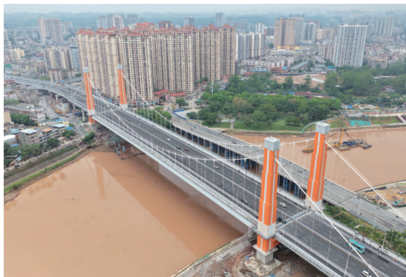
这是4月28日拍摄的建成通车的平陆运河子材大桥(无人机照片)。4月28日,平陆运河关键跨河通子材大桥正式通车,标志着平陆运河规划的27座跨河桥梁全部建成。
